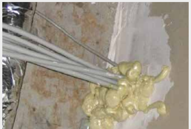
Chiusura effettuata con materiale non idoneo (schiuma monocomponente non intumescente)
