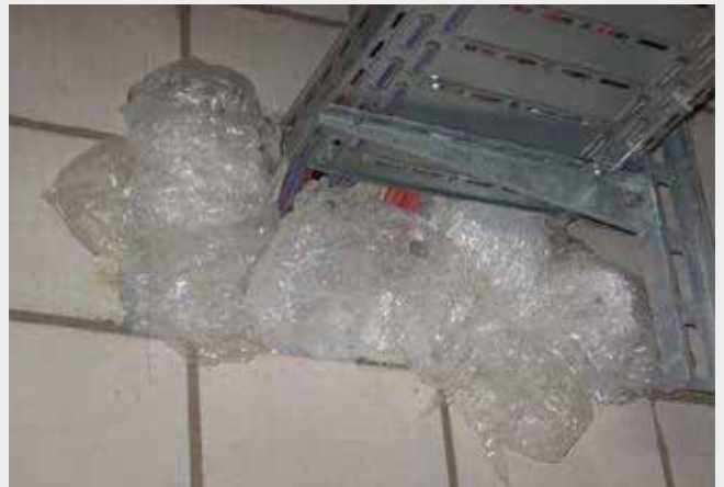
Chiusura con materiale non idoneo (nylon)
