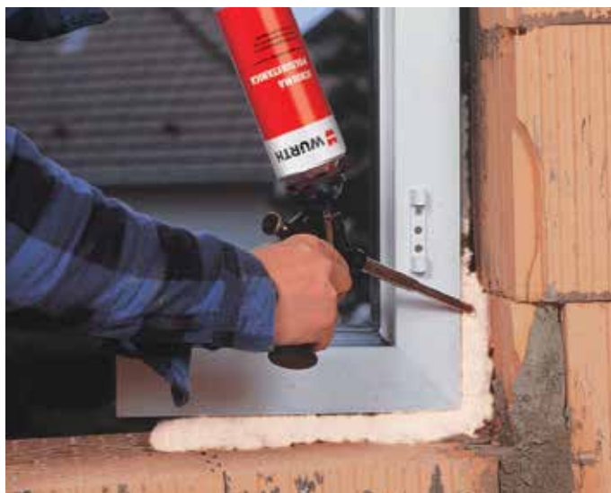
Montaggio di infissi
