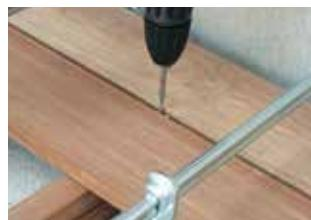
La seconda asse va appoggiata contro la prima con l'ausilio di uno strettoio. Successivamente si fissa la lamella con una vite. Ripetere l'operazione fino a completamento.
