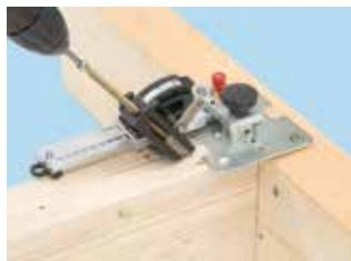
4. Regolare la posizione della piastra di fissaggio e fissarla con l'apposita leva rossa autobloccante, regolare la posizione del punto di entrata, avvitare la vite nella trave secondaria fino alla battuta
