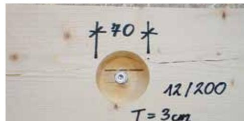
Fresatura: profondità 3 cm / diametro 7 cm
