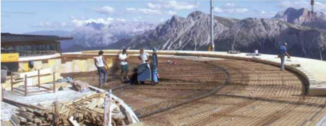
Immagine 5.8 Realizzazione di un solaio composto legno-clt con viti Würth Assy Plus VG
