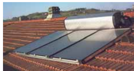
Impianto solare termico
