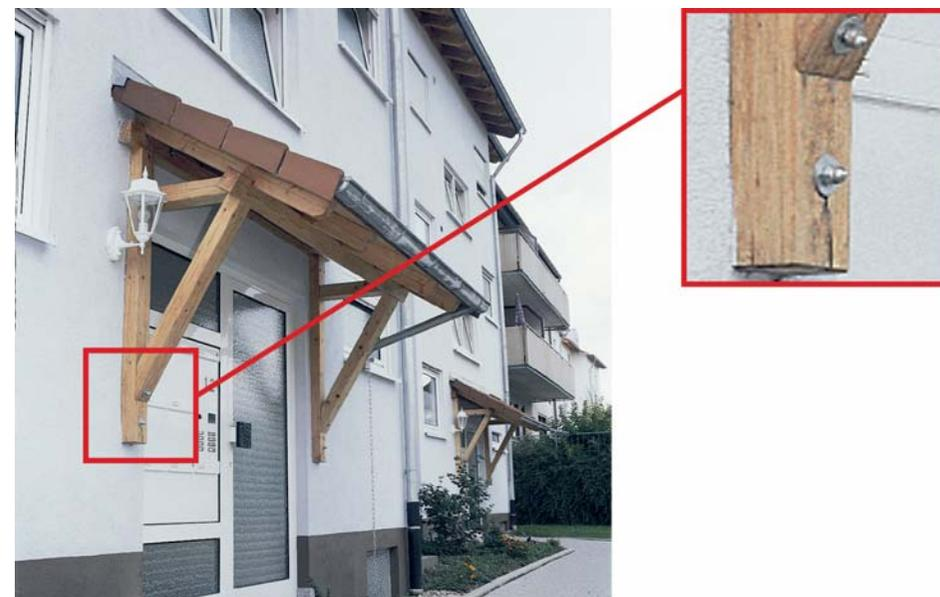
Fig. 2.9: fissaggio di una pensilina in muratura con ancorante ad iniezione Würth WITC200 e barra filettata M12, A4
