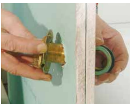
Esempio di montaggio terminale flangiato
