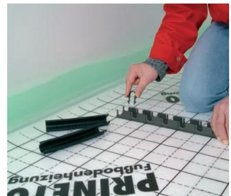
con gli adattatori di allacciamento **RAP** stringere (ad es. art. 0878 386 011). I tubi vanno protetti nel passaggio dalla cassetta al pavimento mediante guaine protettive (art. 0878 386 103) oppure curve di sostegno (art. 0878 900 744). Il passo di posa consentito dalle scanalature dei binari è di 50 mm e multipli, fermo restando il rispetto delle prescrizioni riportate nell'eventuale progetto.
